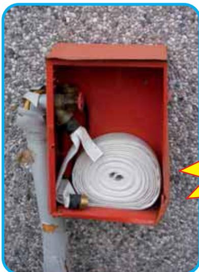
Togliendo le lamiere pretagliate sul lato e sul retro della cassetta la si può installare con la tubazione all'esterno della stessa senza dover smontare il rubinetto.
